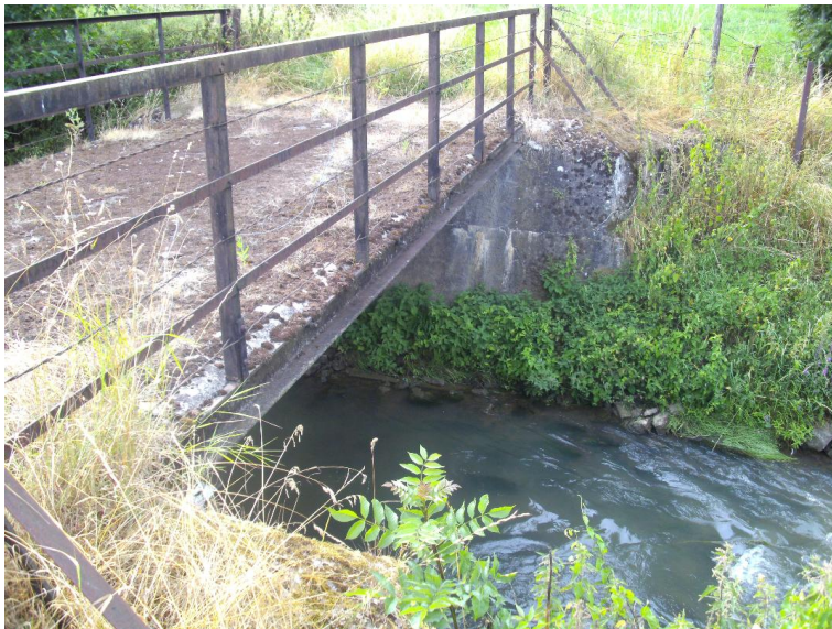
Durchlass; Ufer unterbrochen
