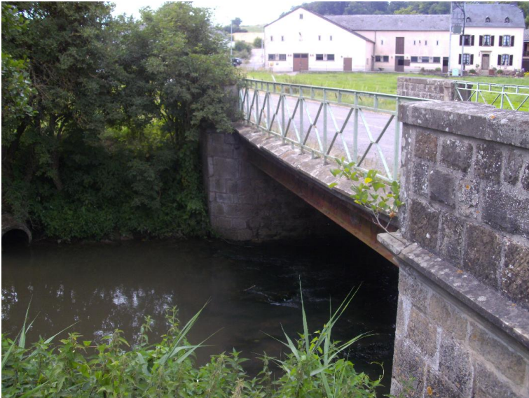
Durchlass; Ufer unterbrochen
