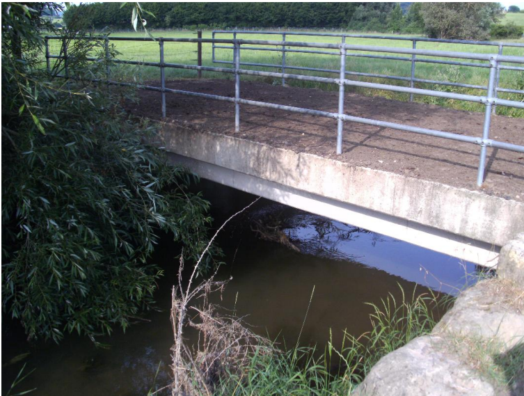
Durchlass; Ufer unterbrochen
