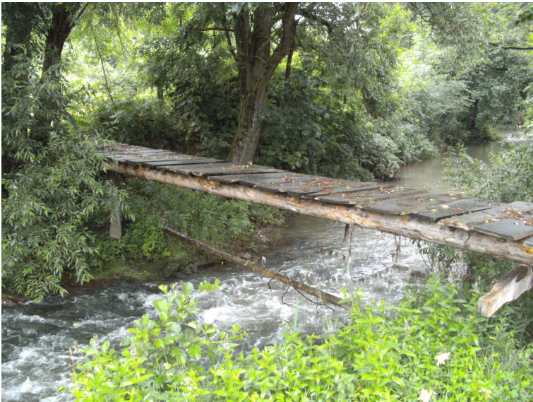
Durchlass; nicht strukturschädlich
