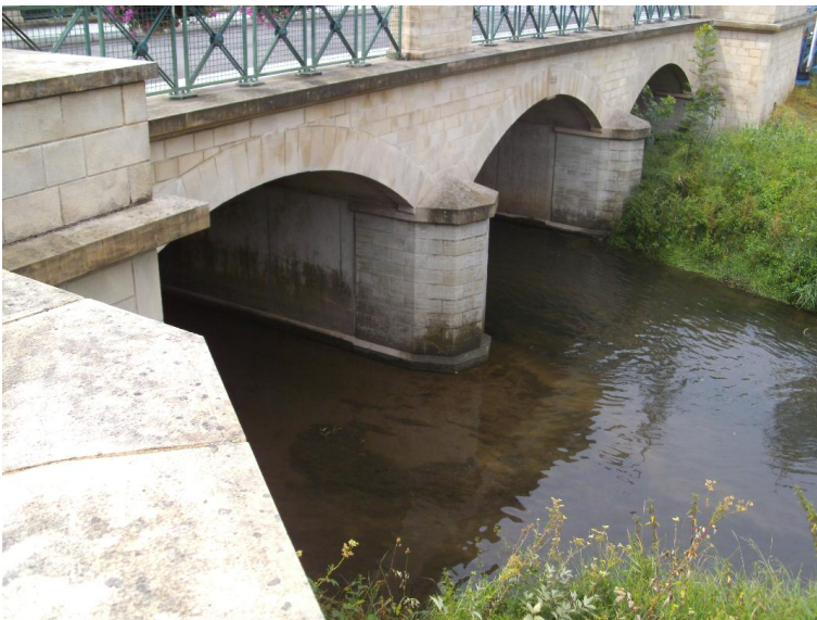
Durchlass; Ufer unterbrochen
