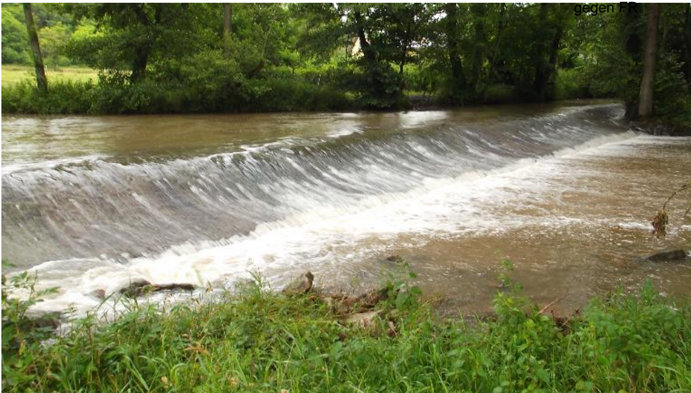
Raue Rampe mit Aufweitung
