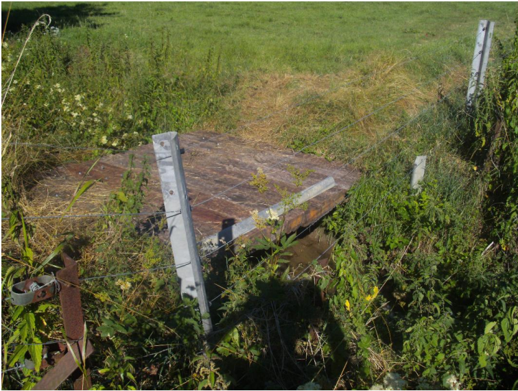
Durchlass; Ufer unterbrochen
