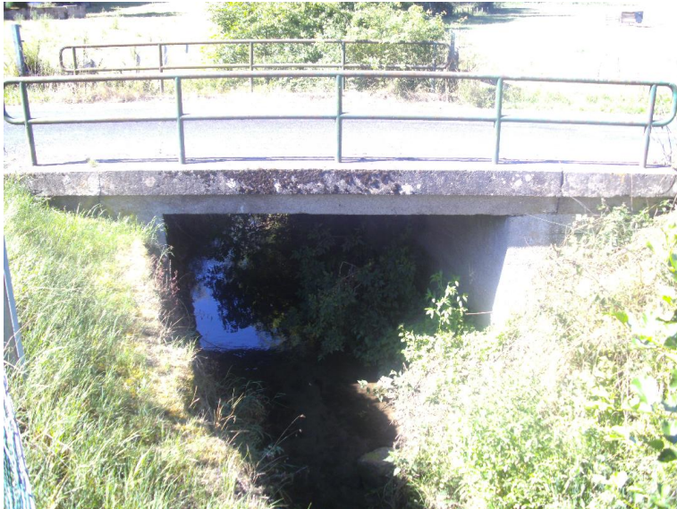
Durchlass; Ufer unterbrochen
