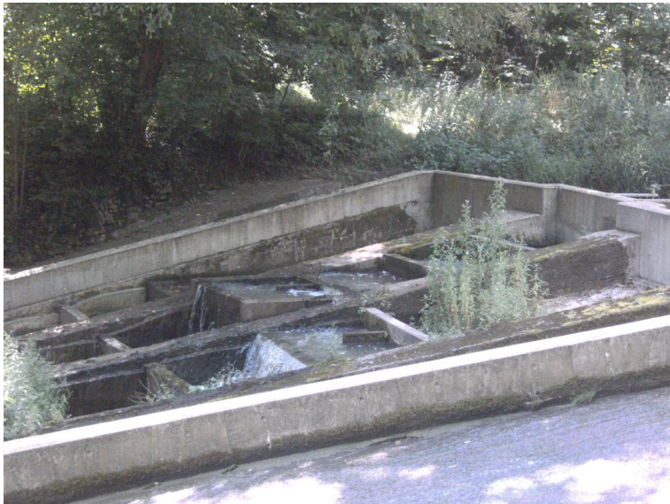
Raue Rampe mit Fischdurchlass
