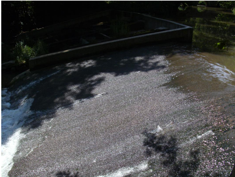
Raue Rampe mit Fischdurchlass
