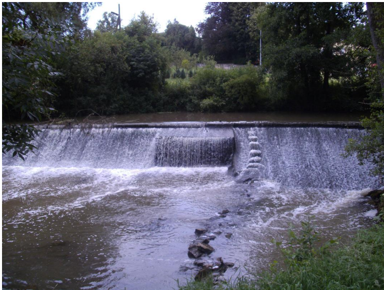
Raue Rampe mit Aufweitung
