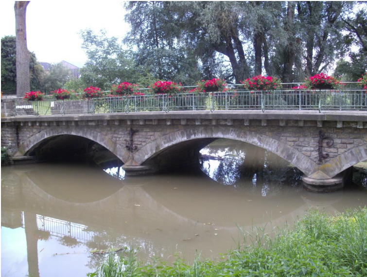
Durchlass; Ufer unterbrochen
