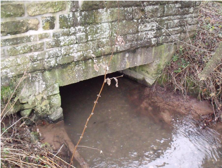
Durchlass; Ufer unterbrochen
