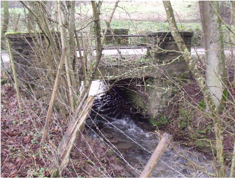
Durchlass; Ufer unterbrochen
