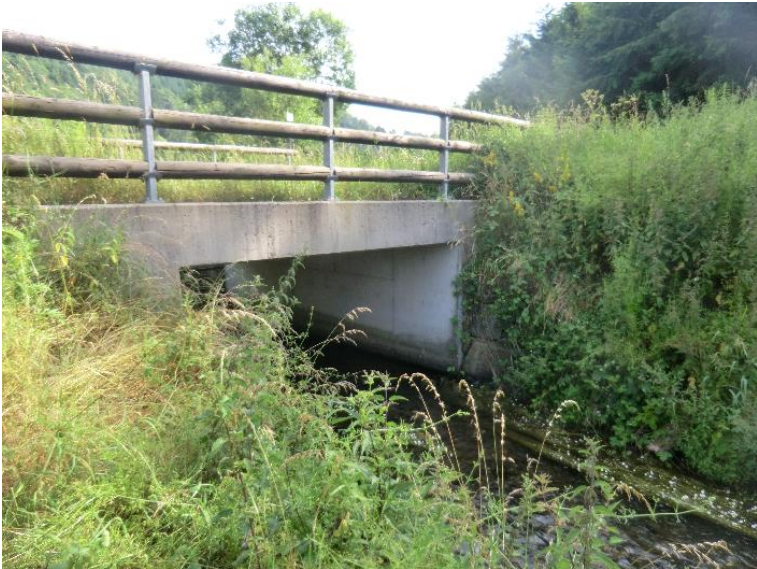
Durchlass; Ufer unterbrochen
