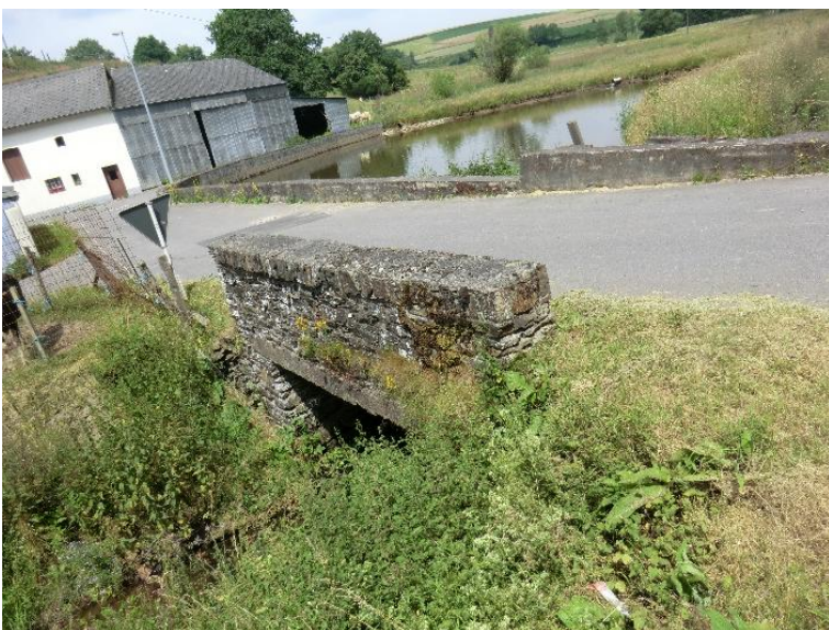
Durchlass; Ufer unterbrochen
