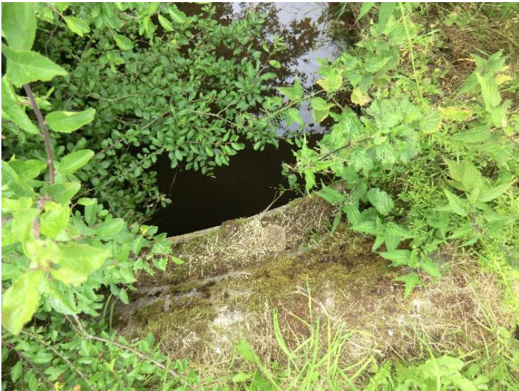
Durchlass; Ufer unterbrochen
