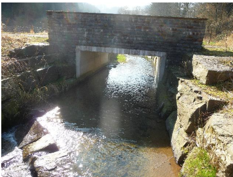
Durchlass; Ufer unterbrochen
