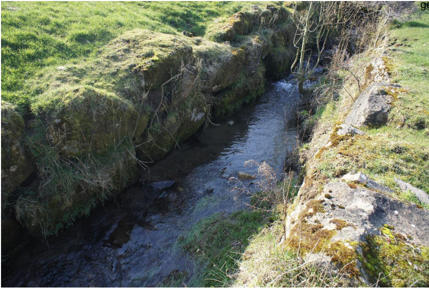
Uferbefestigung durch Steinblöcke
