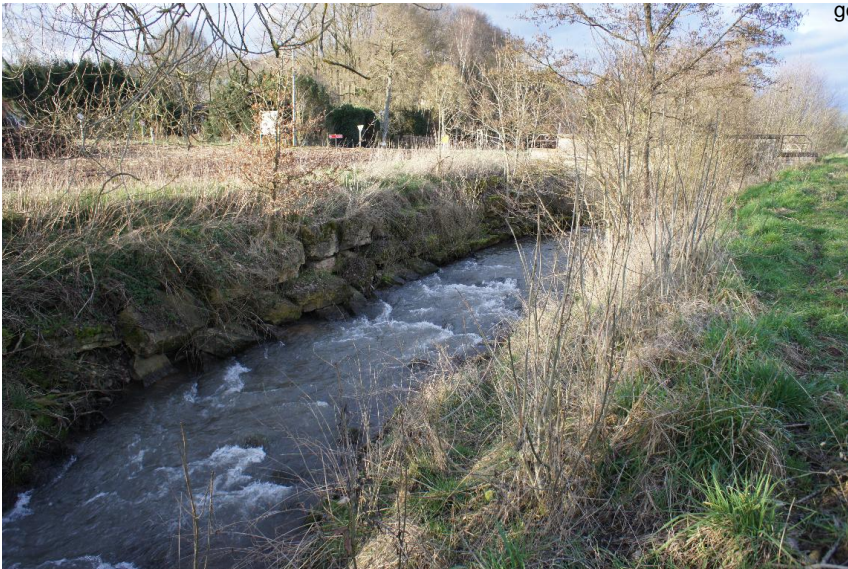
Uferbefestigung durch Steinblöcke
