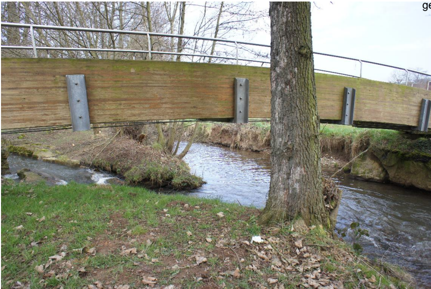
Zulauf Seitengraben - Durchlass; nicht strukturschaedlich - Erosion
