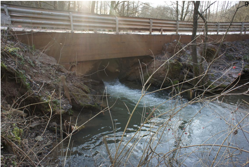
Absturz aus Verrohrung - Durchlass; Lauf verengt
