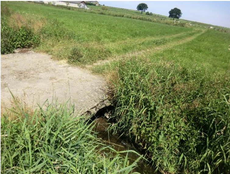
Durchlass; Ufer unterbrochen
