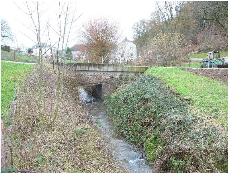
Durchlass; Ufer unterbrochen
