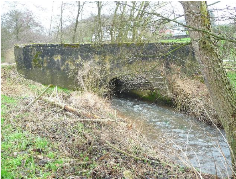
Durchlass; Ufer unterbrochen
