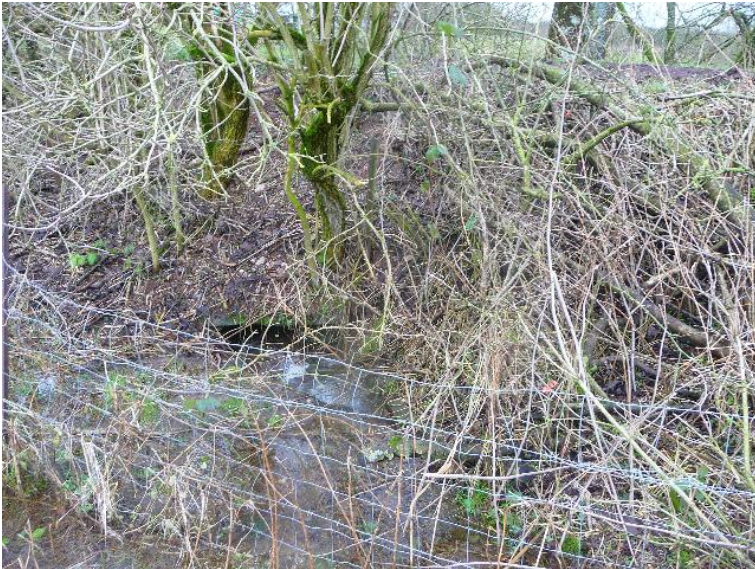
Durchlass; Ufer unterbrochen
