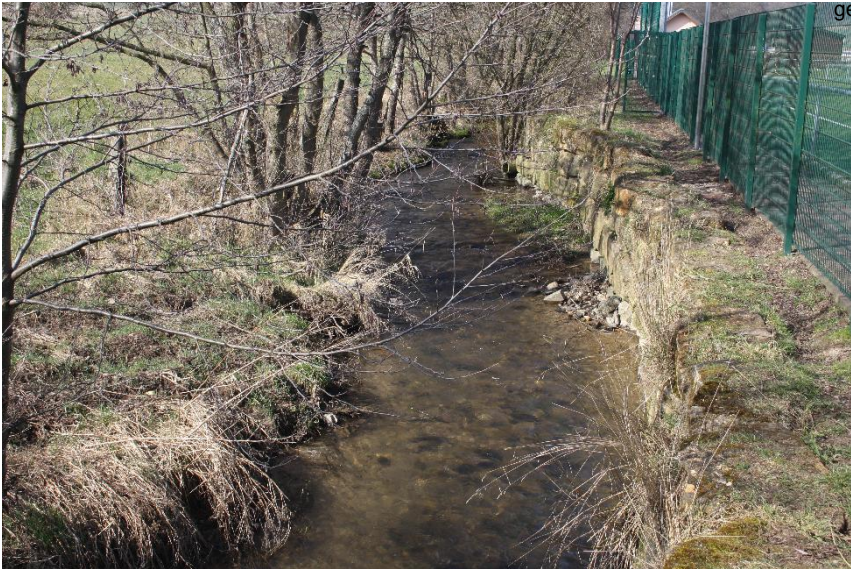
Pflaster, Steinsatz unverfugt
