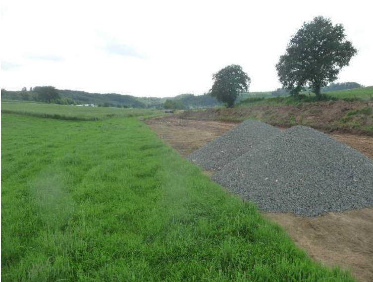
verrohrt bzw. ueberdeckt
