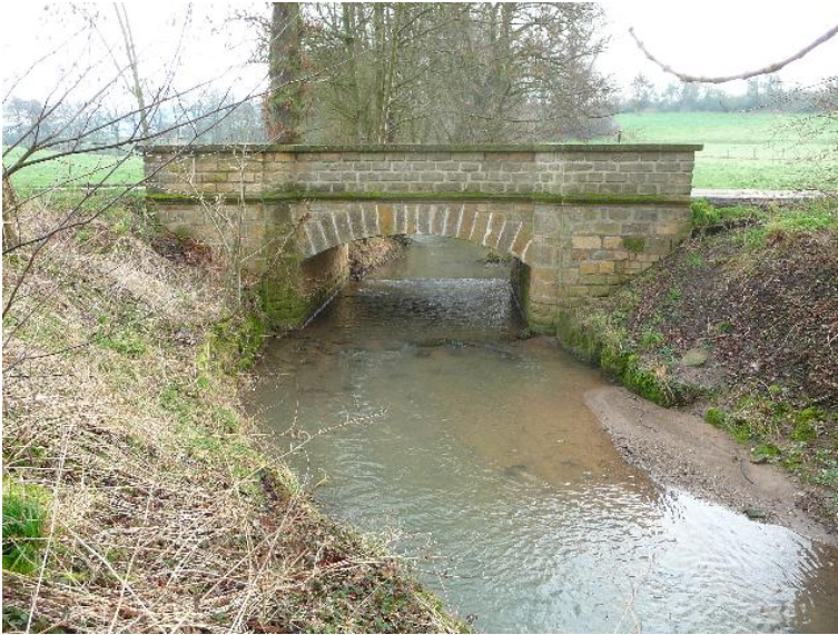
Durchlass; Ufer unterbrochen
