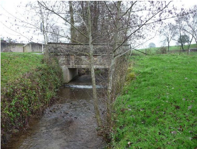
Durchlass; Ufer unterbrochen
