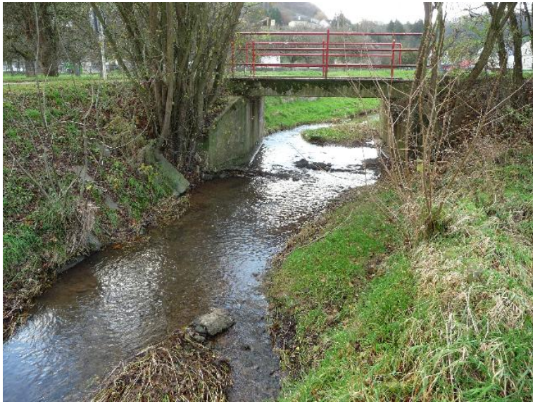
Durchlass; Ufer unterbrochen
