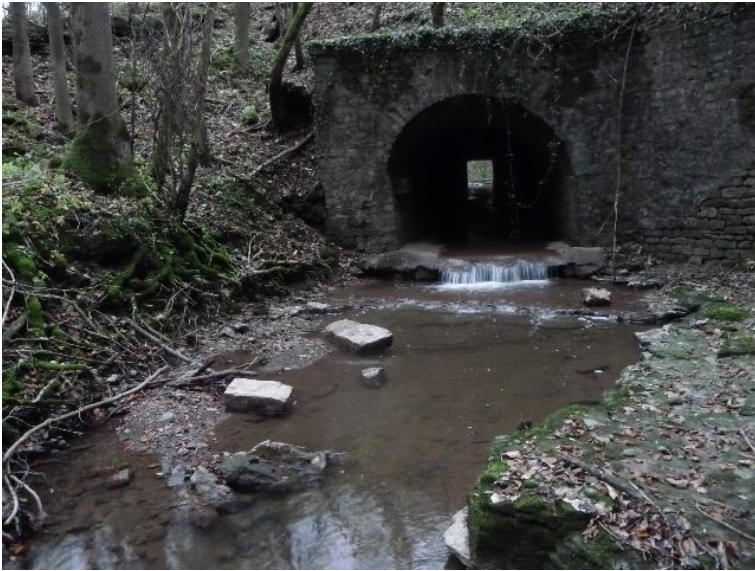
Durchlass; Ufer unterbrochen
