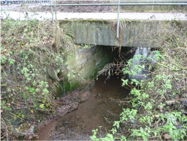
Durchlass; Ufer unterbrochen
