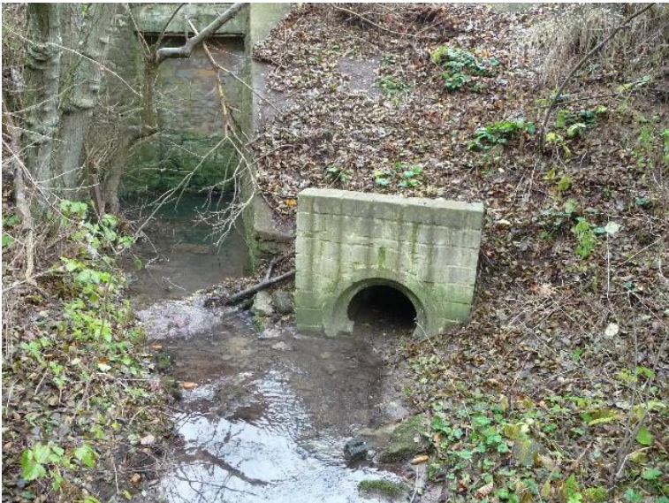
Durchlass; Ufer unterbrochen
