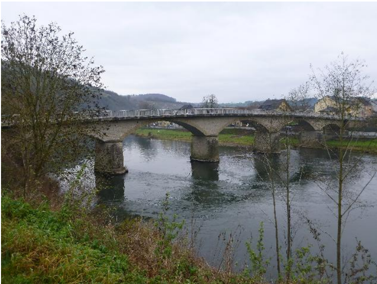
Durchlass; Lauf verengt
