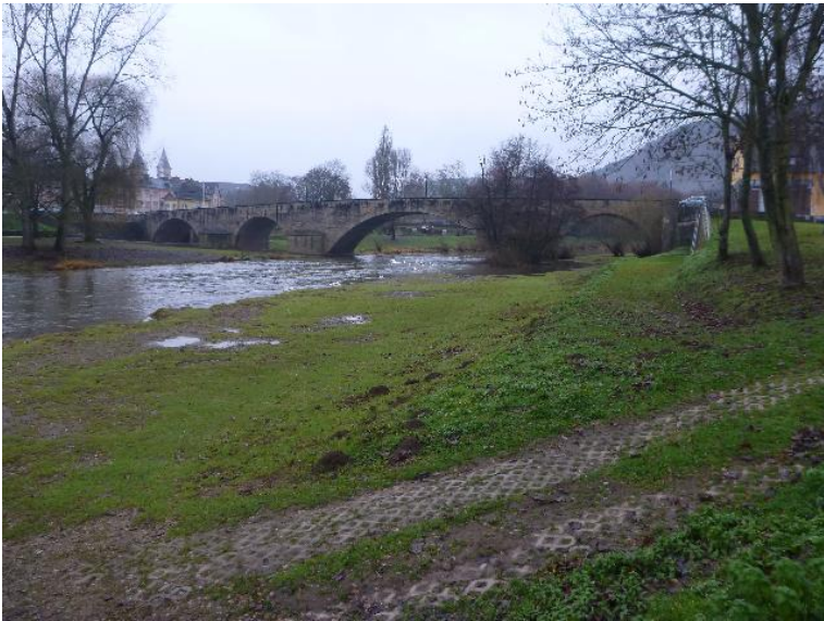
Durchlass; Lauf verengt
