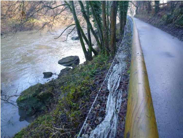
Uferverbau Steinsatz unverfugt
