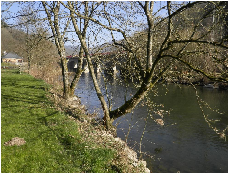
Durchlass; Ufer unterbrochen
