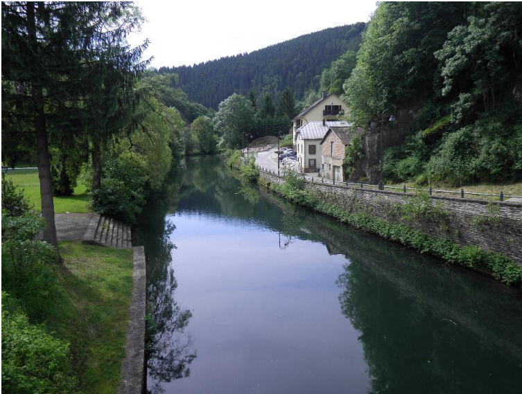
Bebauung mit Freifläche
