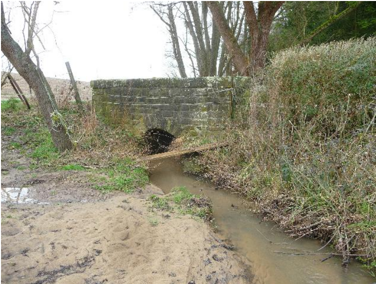
Durchlass; Ufer unterbrochen
