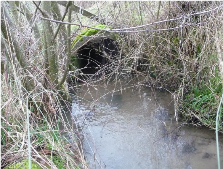
Durchlass; Ufer unterbrochen
