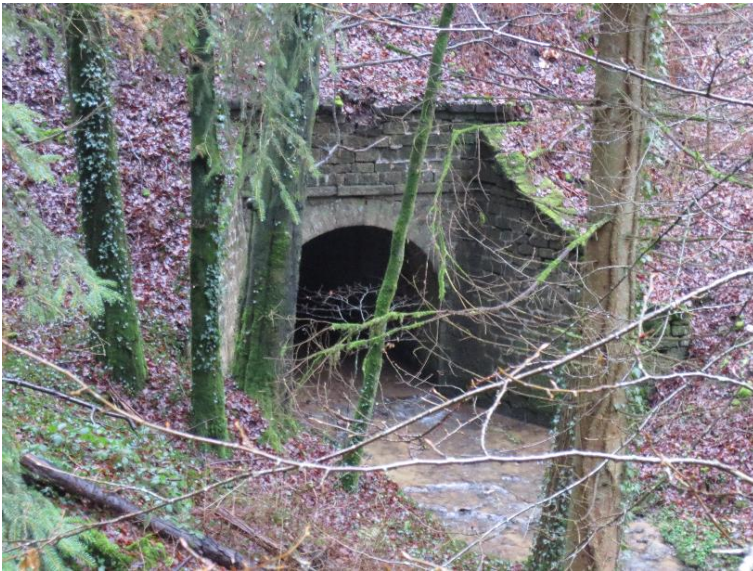
Durchlass; Ufer unterbrochen
