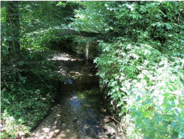
Durchlass; Ufer unterbrochen
