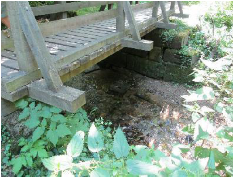
Durchlass; Ufer unterbrochen
