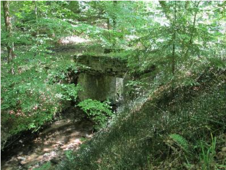
Durchlass; Ufer unterbrochen
