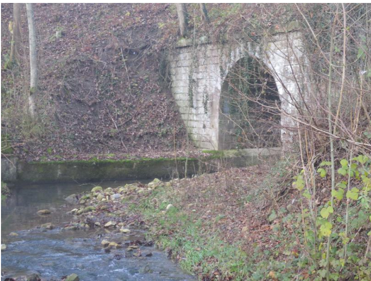
Durchlass; Ufer unterbrochen
