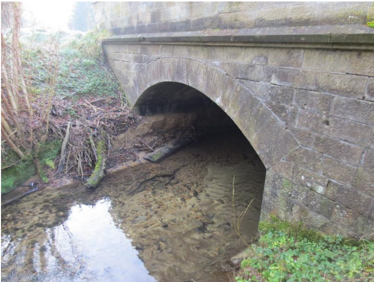
Durchlass; Ufer unterbrochen
