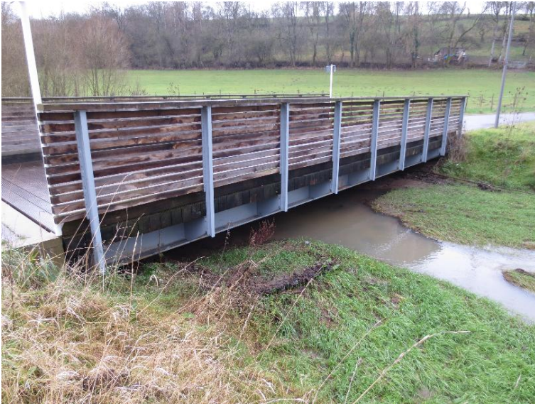
Durchlass; Ufer unterbrochen
