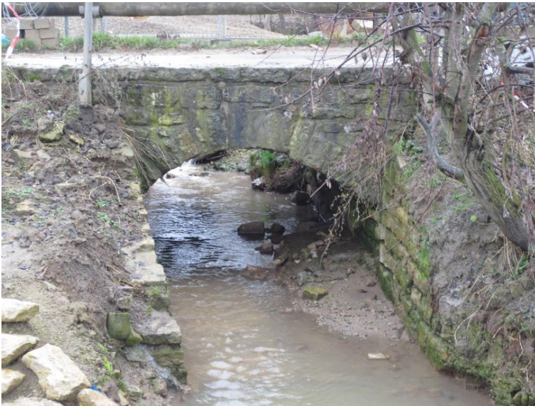
Durchlass; Ufer unterbrochen
