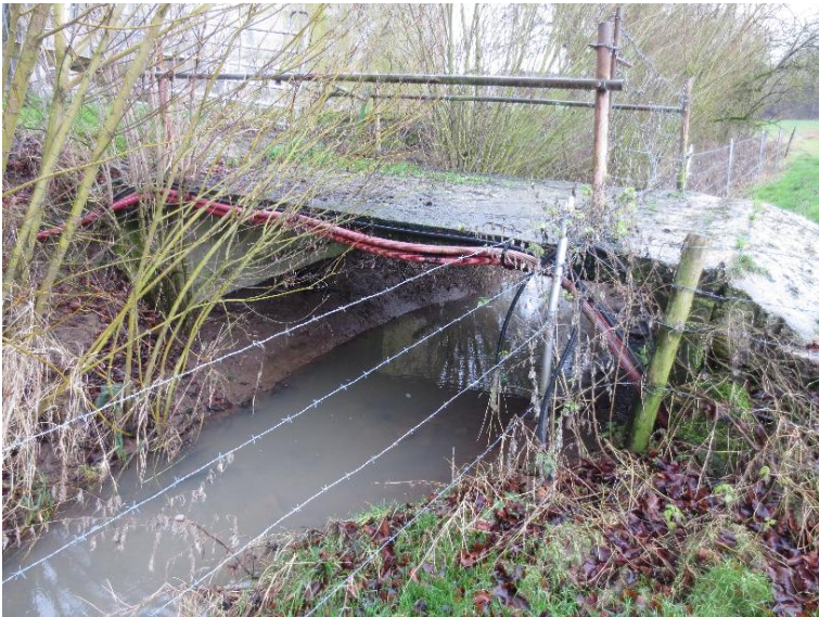
Durchlass; Ufer unterbrochen
