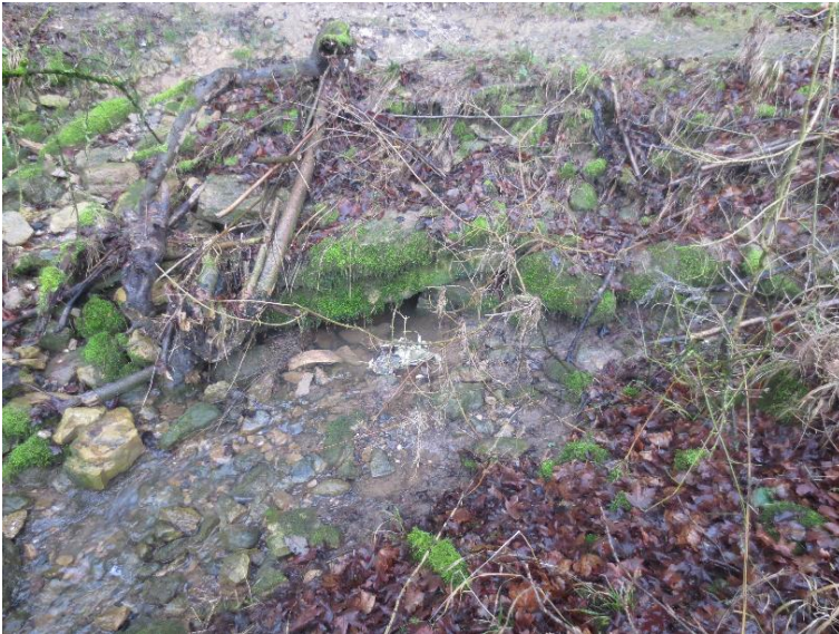
Durchlass; Ufer unterbrochen
