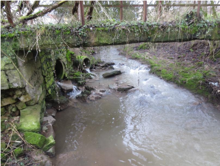
Durchlass; Ufer unterbrochen
